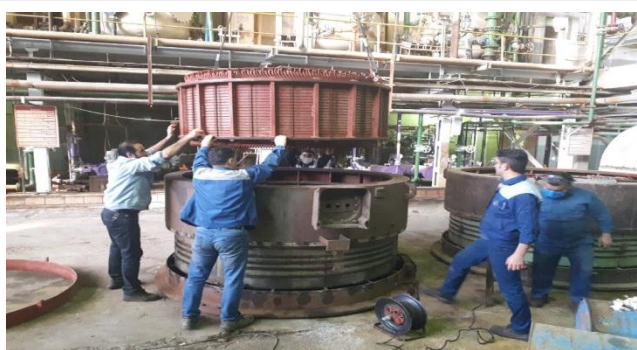
بازسازی و تعمیر الکتروموتور برجهای خنک کن
