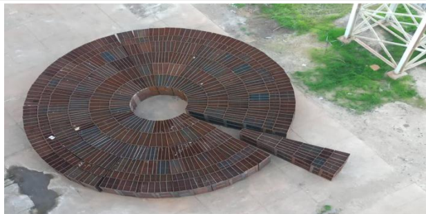
چیدمان بسکت های لایه گرم واحد ۶ جهت تعویض در تعمیرات اساسی
