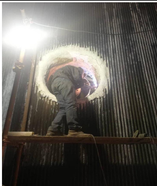
جوشکاری و رفع عیب نازل و دهانه مشعلهای واحد ۳
