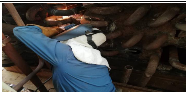
تعویض شبانه روزی لوله های معیوب اکونومایزر شماره یک استارت بویلر ۴_۱
