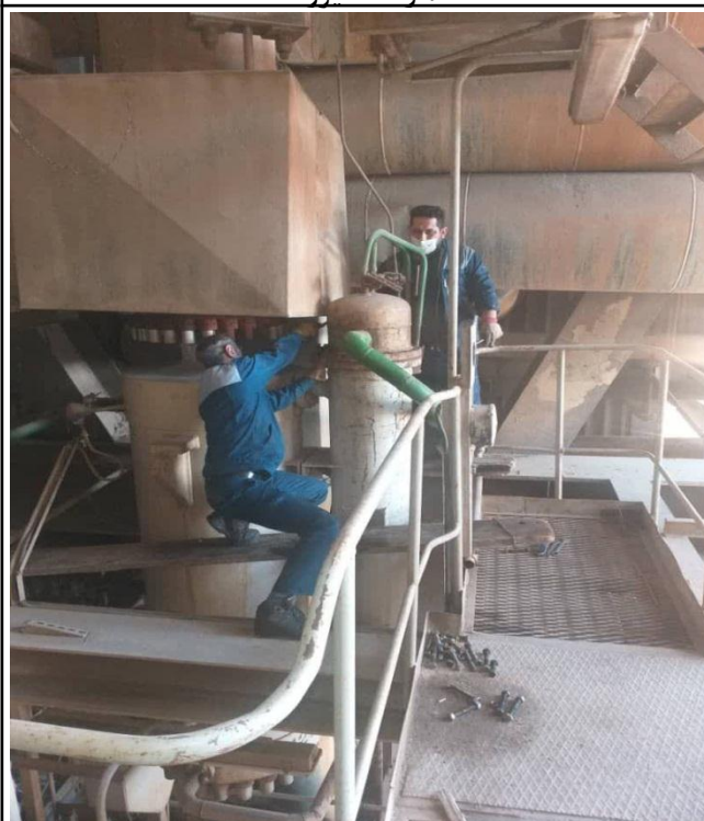
باز کردن و سرویس کولرهای HPC واحد ۶
