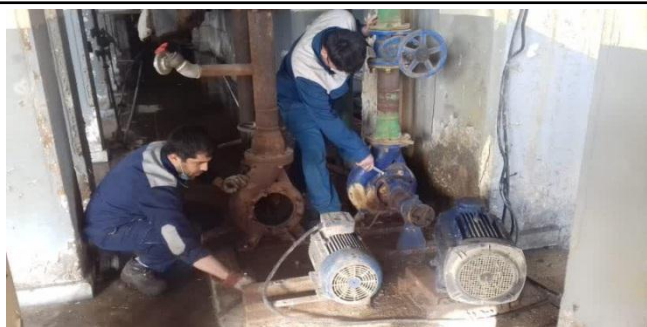
باز کردن پمپهای تغذیه کمپرسورهای واحد ۵ و ۶ جهت تعمیر اساسی
