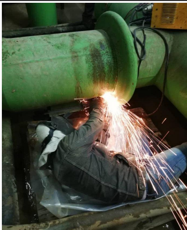
جوشکاری و رفع عیب نازل و دهانه مشعلهای واحد ۳
