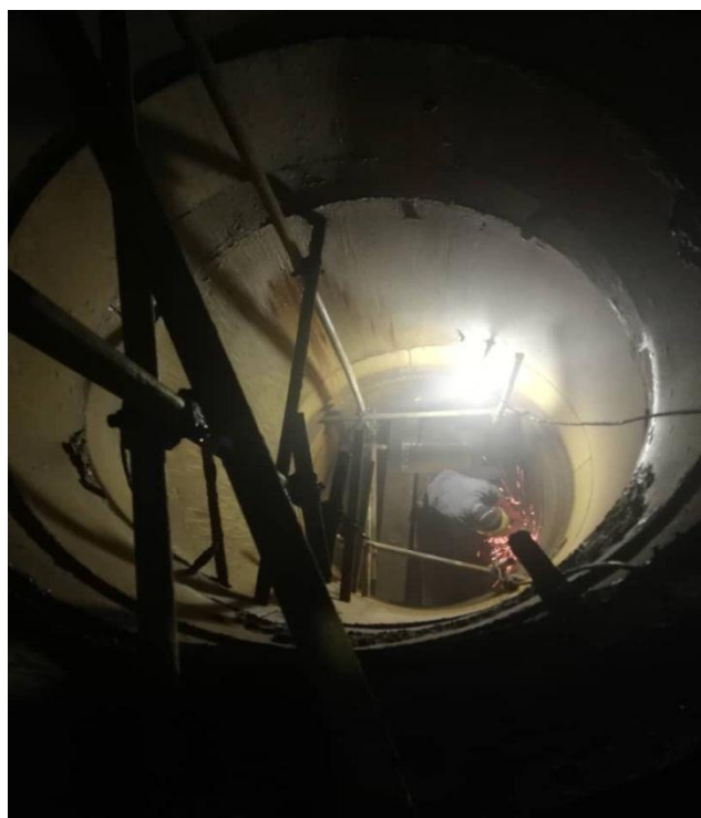
جوشکاری ورودی کندانسور شاخه B واحد ۳
