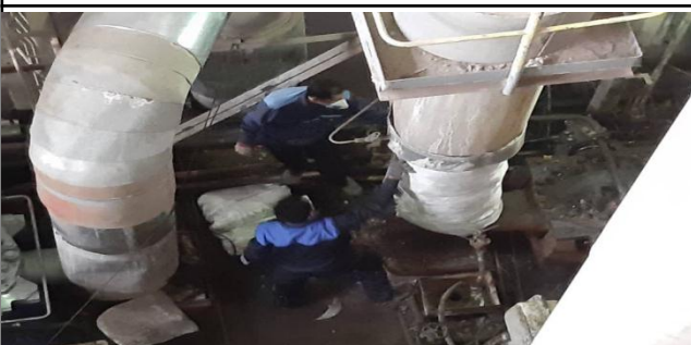
عایق کاری و ورق کاری مسیرهای ورود و خروج بوستر پمپ ها واحد ۳
