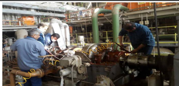
دمونتاژ هیدروکوپلینگ فید پمپ B واحد ۶
