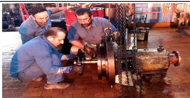
باز کردن پمپ مرحله دوم مازوت خانه ۳۰۴ جهت تعمیر و سرویس و مونتاژ آن
