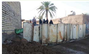
ساخت سیل بند متحرک شهر ویس توسط جهادگران بسیجی نیروگاه رامین
