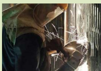
ترانشکاری و رزروسازی سیلندر ولو خروجی فیدپمپ نیروگاه رامین اهواز
