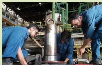
رفع گرفتگی از بولورهای هوای خنک کن سنسورهای حفاظت شعله بویلر های ۱ تا ۱۲ نیروگاه رامین
