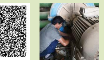
رفع گرفتگی از بولورهای هوای خنک کن سنسورهای حفاظت شعله بویلر های ۱ تا ۱۲ نیروگاه رامین
