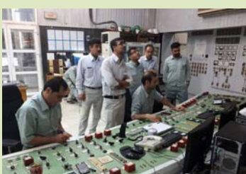
عملیات سستشوی مفره های ترانس اصلی واحد ۱ نیروگاه افق ماهشهر
